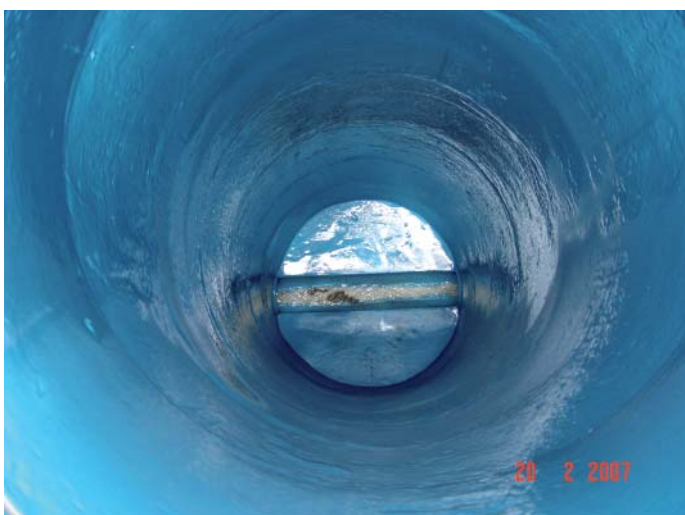
Schacht mit PUR beschichtet
